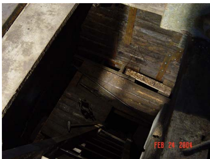
Obr.1 Pohľad do šachty Leopold
