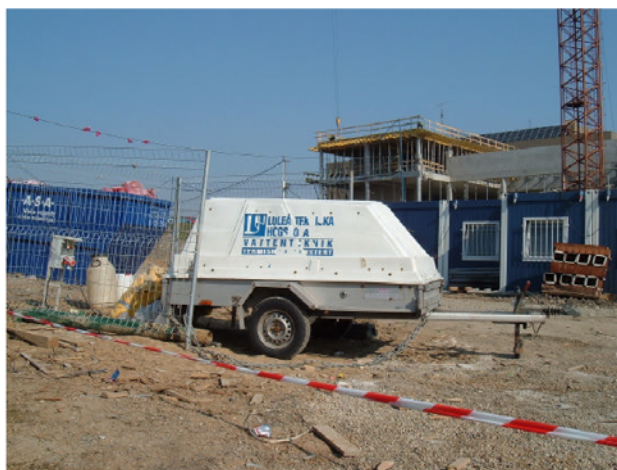
Obr. 2. Testovací zařízení na zkušebním vrtu pro technickou univerzitu VŠB v Ostravě.
