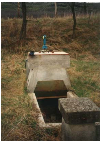
Obr. 1b. Stabilizácia bodov základnice Fig. 1b. Stabilization of baseline points
