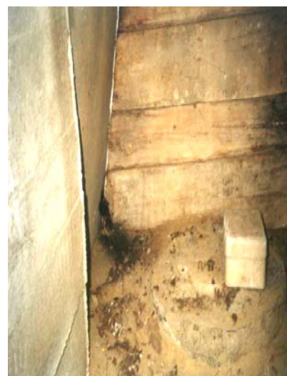
Obr. 1c. Podzemná stabilizácia Fig. 1c. Underground stabilization
