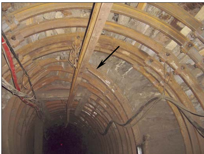
Foto 1. Tlakové prejavy banského diela (dôsledky nadvýlomu v strope banského diela) Baňa Nováky, o.z.
