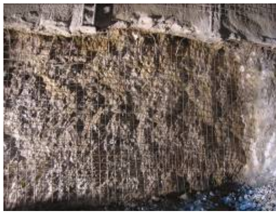
Obr. 2. Zabudovanie výstužných prvkov v technologickej triede II. časť lavica.
