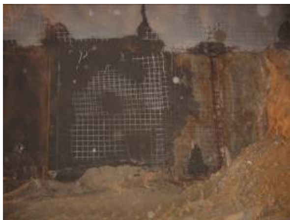
Obr. 7. Zabudovanie výstužných prvkov v technologickej triede IV. časť lavica. Fig. 7. Installing of support elements in supporting class IV. part bench.
