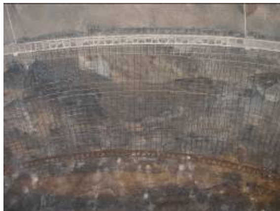
Obr. 4. Zabudovanie výstužných prvkov v technologickej triede III, časť kalota. Fig. 4. Installing of support elements in supporting class III, part calotte.
