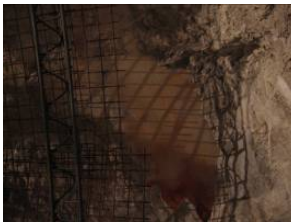
Obr. 12. Zabudovanie výstužných prvkov v technologickej triede IV. časť kalota.
