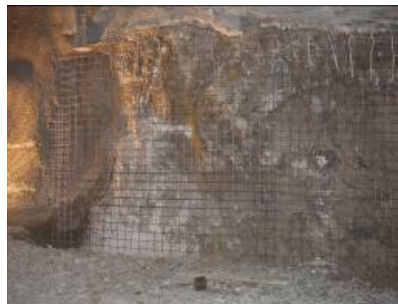
Obr. 6. Zabudovanie výstužných prvkov v technologickej triede III, časť lavica. Fig. 6. Installing of support elements in supporting class III, part bench.
