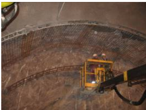
Obr. 11. Zabudovanie výstužných prvkov v technologickej triede IV. časť kalota.
