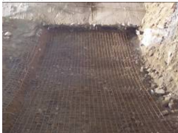
Obr. 10. Zabudovanie výstužných prvkov v technologickej triede IV. časť dno. Fig. 10. Installing of support elements in supporting class IV. part invert.
