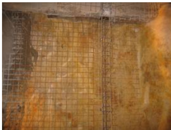
Obr. 14. Zabudovanie výstužných prvkov v technologickej triede IV. časť lavica. Fig. 14. Installing of support elements in supporting class V. part bench.
