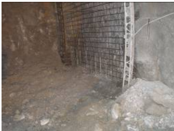
Obr. 3. Zabudovanie výstužných prvkov v technologickej triede III, časť kalota. Fig. 3. Installing of support elements in supporting class III, part calotte.
