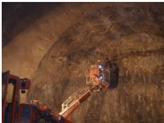
Obr. 1. Zabudovanie výstužných prvkov v technologickej triede II. časť kalota.
