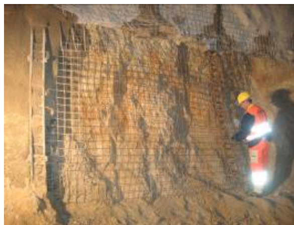
Obr. 8. Zabudovanie výstužných prvkov v technologickej triede IV. časť lavica. Fig. 8. Installing of support elements in supporting class IV. part bench.
