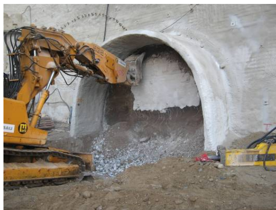
Obr. 2. Pilierová štôľňa – VP. Fig. 2. Pillar adit – EP.
