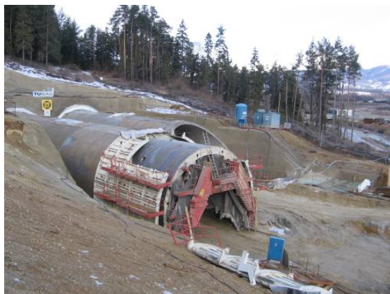
Obr. 15. Hĺbený tunel – VP.
