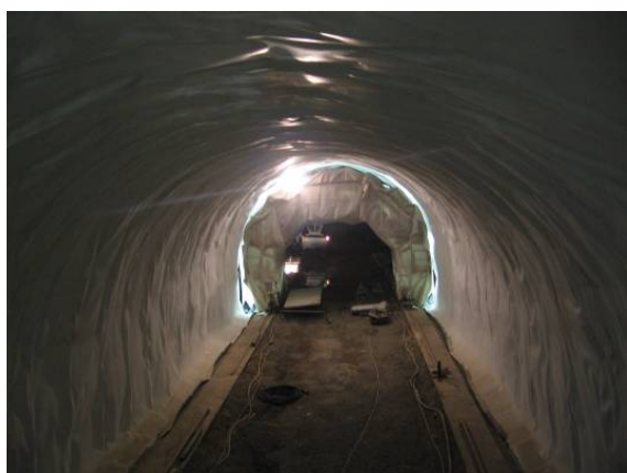
Obr. 9. Izolácia – VP. Fig. 9. Waterproofing layer – EP.
