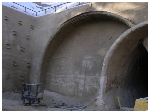
Obr. 4. Začiatok razenia – VP – pravá tunelová rúra. Fig. 4. Start of driving – EP – left tunnel tube.
