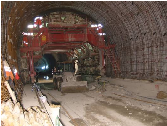
Obr. 11. Sekundárne ostenie – VP.
