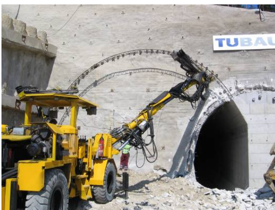
Obr. 5. Začiatok razenia – WP – ľavá tunelová rúra. Fig. 5. Start of boring – WP – left tunnel tube.
