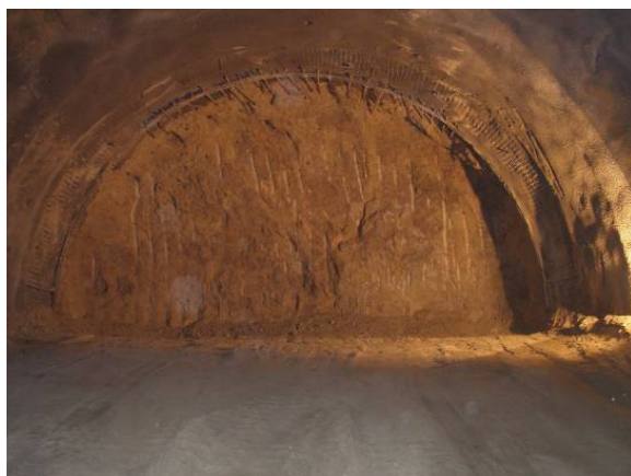
Obr. 7. Primárne ostenie – VP. Fig. 7. Primary lining – EP.
