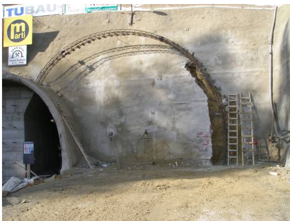
Obr. 3. Začiatok razenia – VP – ľavá tunelová rúra. Fig. 3. Start of driving – EP – left tunnel tube.
