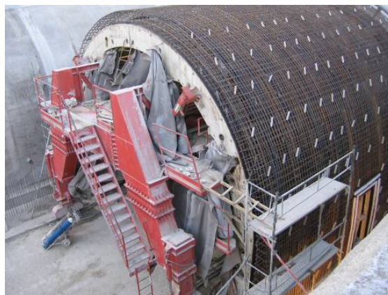
Obr. 16. Hĺbený tunel – VP.
