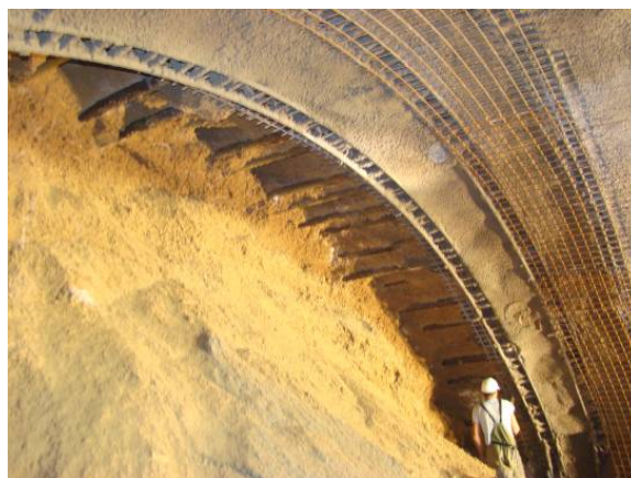
Obr. 8. Primárne ostenie – ZP. Fig. 8. Primary lining – WP.
