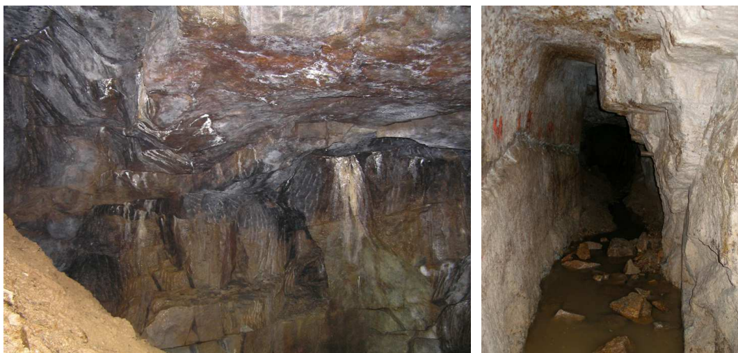
Fig. 2 Photos of manual mining and setting fire in the medieval Jeroným Mine (photo: Lednická)
